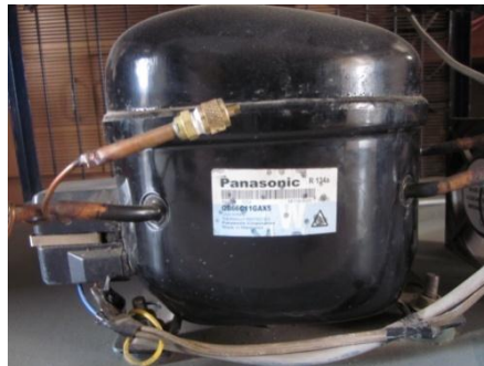
Fig 3.4 : Compressor
